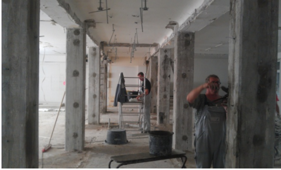
Ansicht 1. OG, fertig ertüchtigte Stützen
