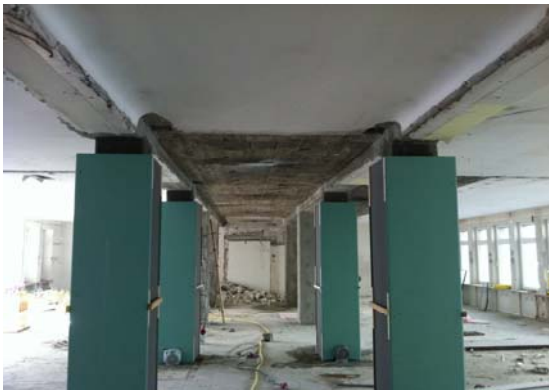
ein gehauste Stützen 1. OG
